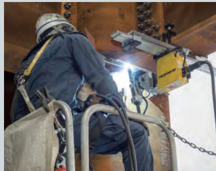
梁下フランジの上向溶接
