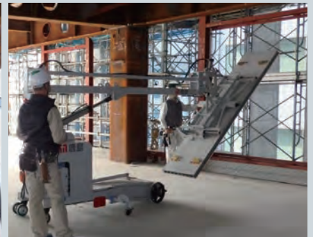
外装取付アシストマシン(マイティフェザー ® )は、操縦する人と取付位置の干渉を確認する人の2人で作業を行う
