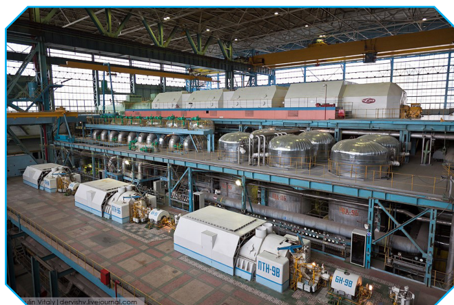
Костромская ГРЭС турбоагрегат 1200 МВт
