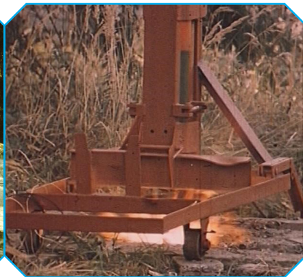
Разрушение взрывогенератором бетонной плиты серией последовательных взрывов
